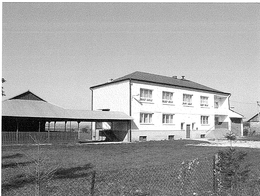
Budynek remizy OSP
