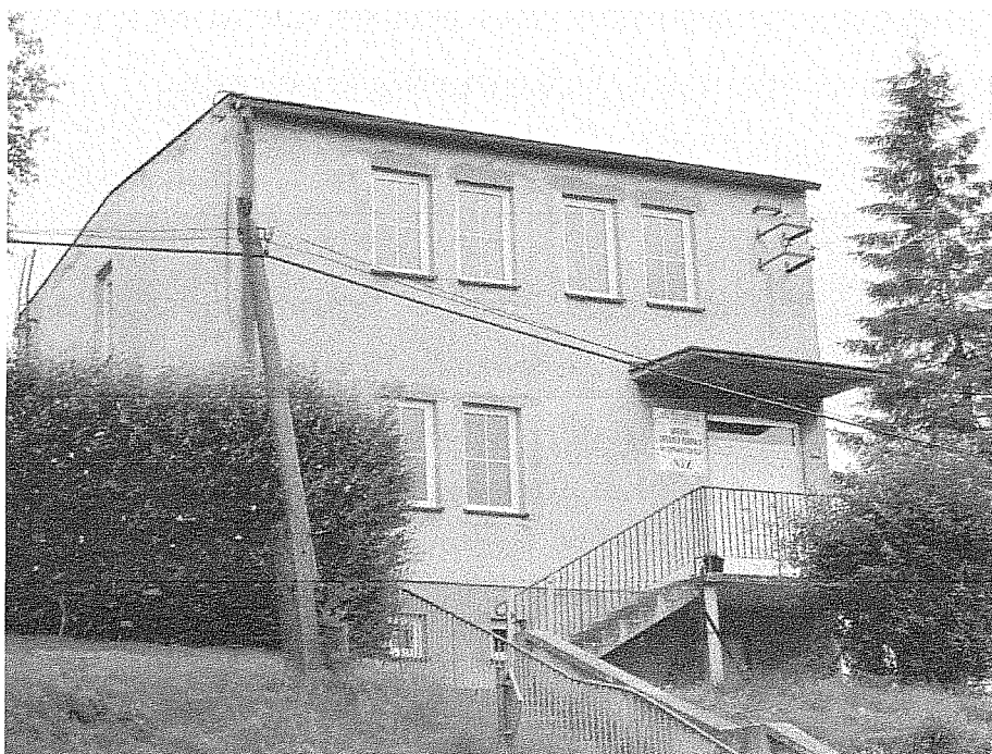
Fot. Nr 4 Budynek Ośrodka Zdrowia w Żurawiczkach
