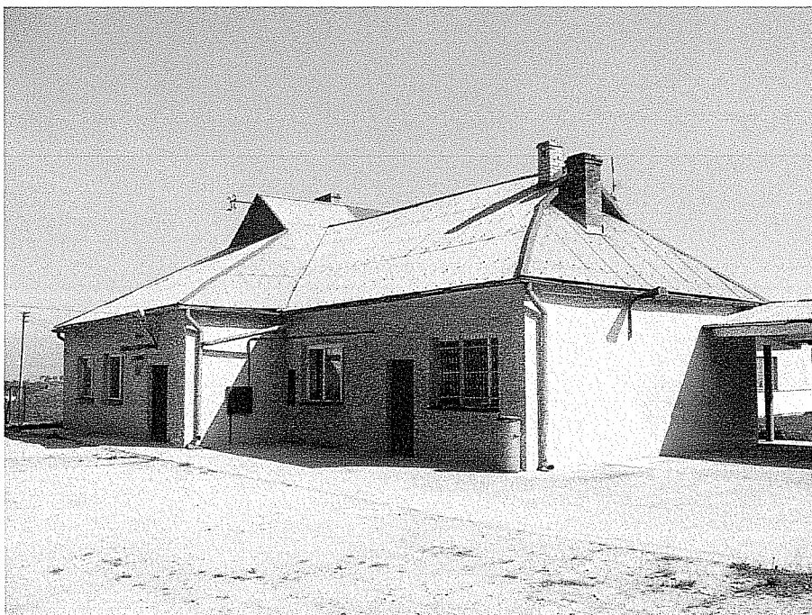
Fot. Nr 5 Budynek Remizy OSP
