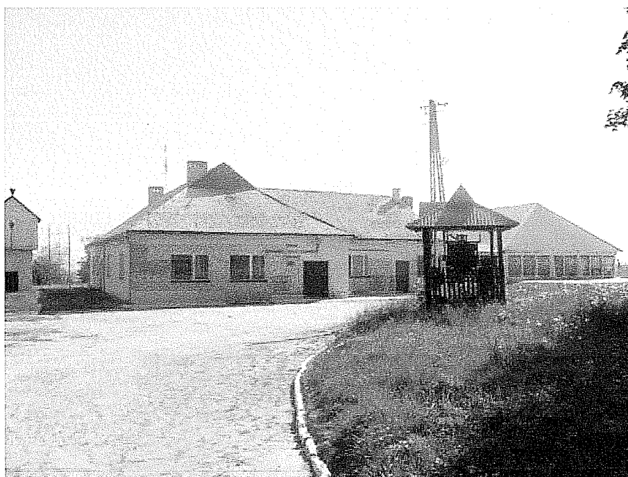
Fot. Nr 3 Widok na Remizę OSP w Siennowie
